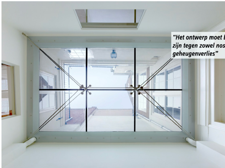
Overdekte binnenplaats aan de Prinsengracht, Amsterdam.
