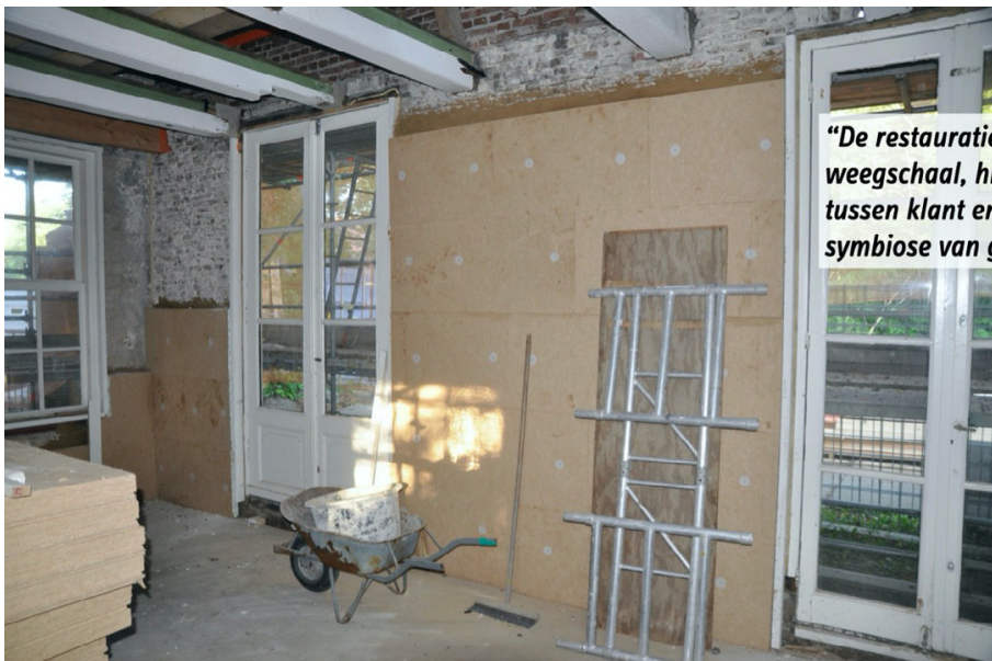
Het aanbrengen van dampopen isolatie bij landgoed Duijnwijk, Beverwijk.
